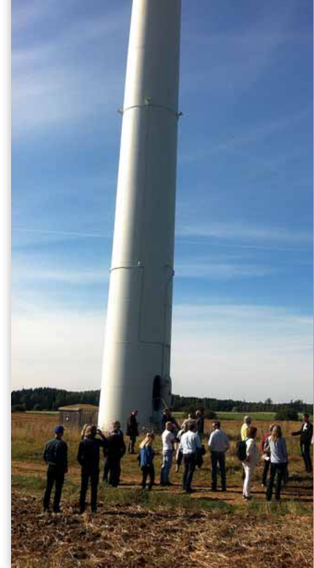
Visita a la instalación piloto de DTBirdV4D4, en Suecia. A la izquierda, detalle del anillo de cámaras y altavoces sobre la torre.
