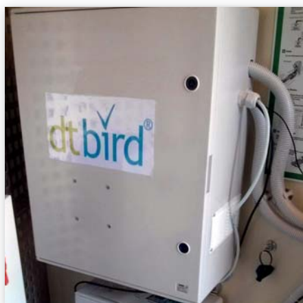
Bando de gansos detectado por DTBird. A la derecha, unidad de análisis instalada en el interior de un aerogenerador. Recibe y procesa en tiempo real la información aportada por las cámaras de alta definición y las lecturas del anemómetro, y toma las acciones necesarias para reducir el riesgo de colisión, y sube a una plataforma de datos online toda la información.
